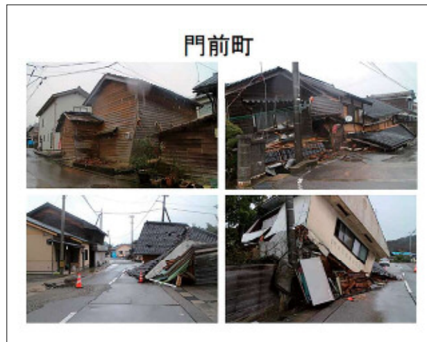
図-36 門前町（輪島市）の被害状況
