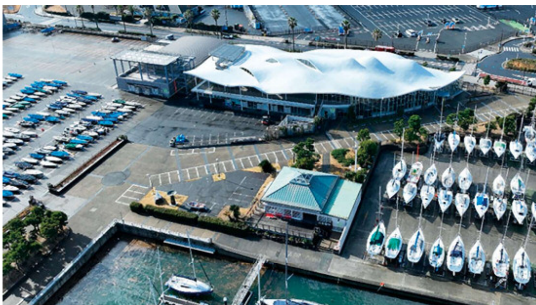
写真-3 江の島津波避難タワー（2025年1月空撮）
