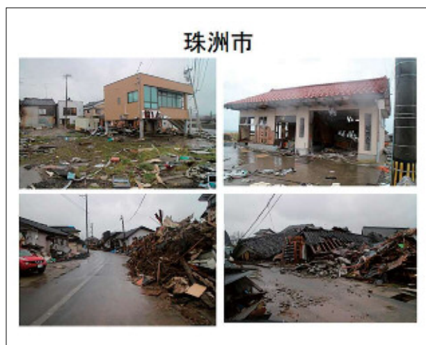
図-27 珠洲市の被害状況③
