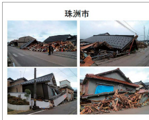
図-24 珠洲市の被害状況
