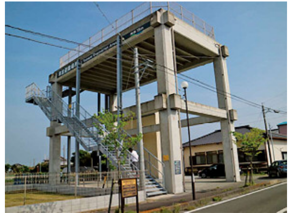
写真-9 静岡県掛川市の開放型津波避難タワー (2023年4月撮影)
