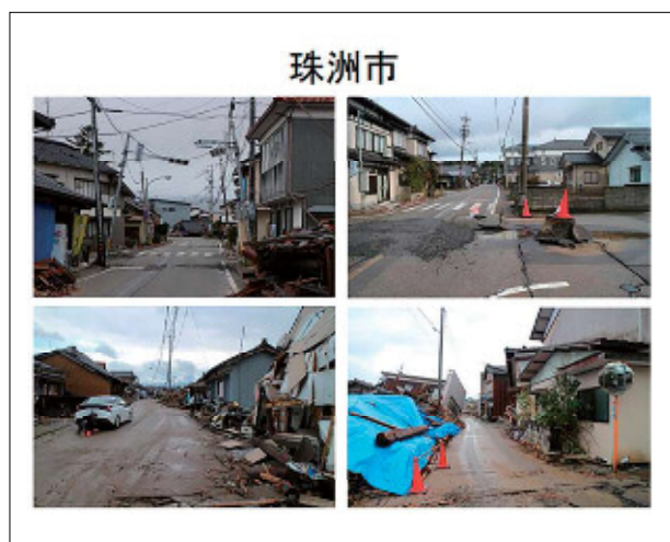
図-25 珠洲市の被害状況①
