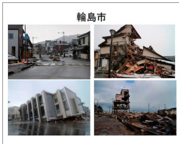
図-23 輪島市の被害状況
