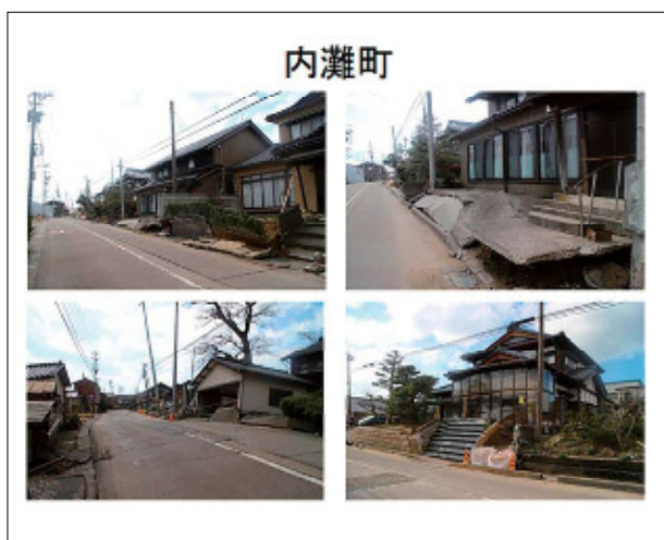
図-39 内灘町の被害状況②
