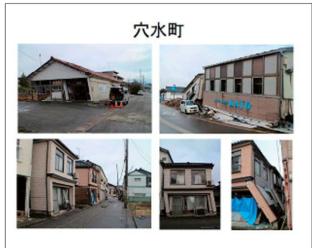
図-30 穴水町の被害状況
