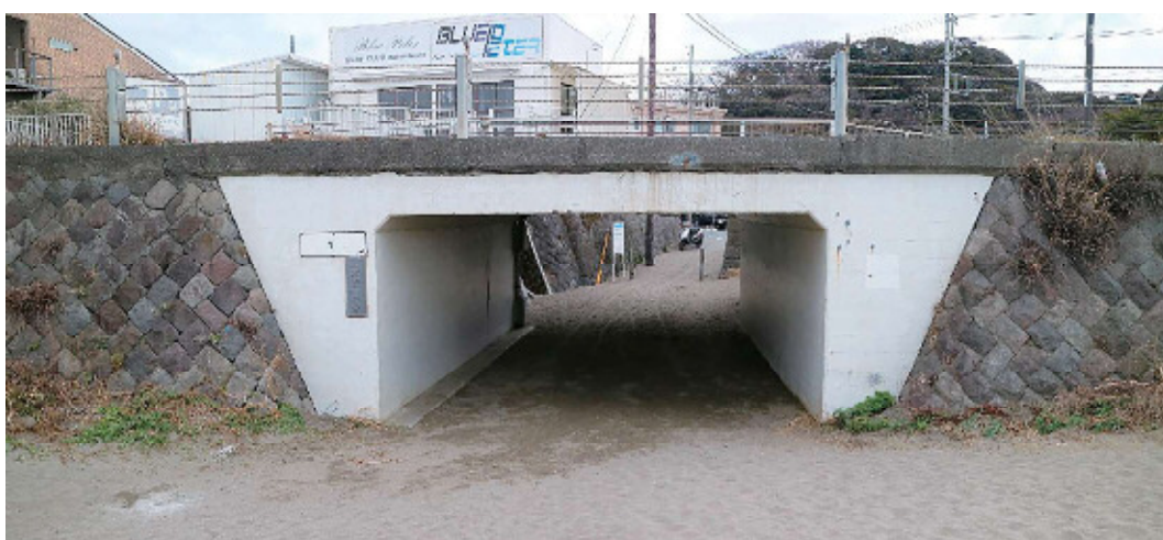
写真-6 鎌倉市 国道134号線下部の歩行者用通路（2025年1月撮影）
