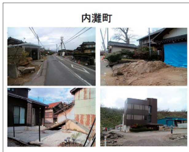
図-38 内灘町の被害状況①
