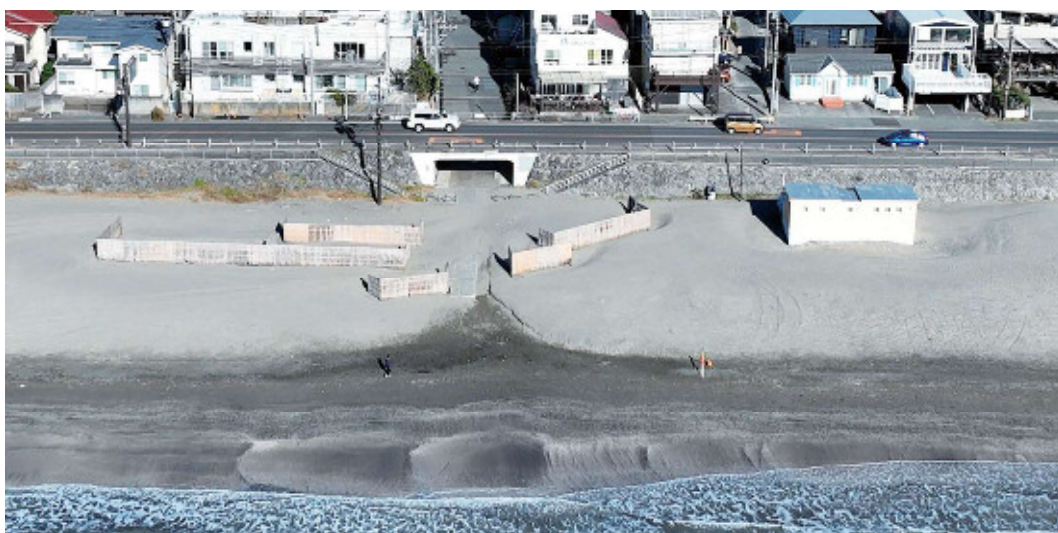
写真-5 鎌倉市 国道134号線下部の歩行者用通路（2024年12月空撮）
