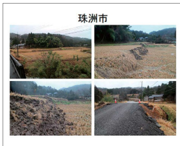
図-28 珠洲市で見られた地盤の隆起
