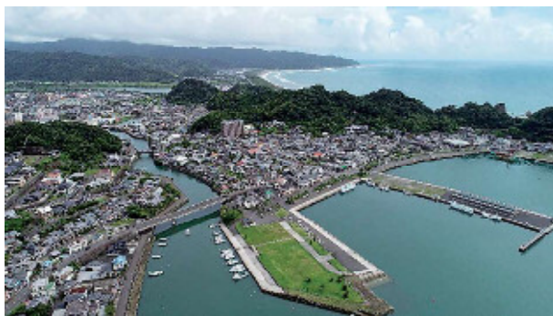
写真-10 日南市油津港と堀川運河（2023 年 8 月空撮）
