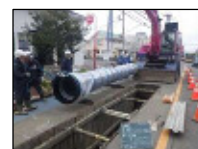
（耐震管の敷設工事）
