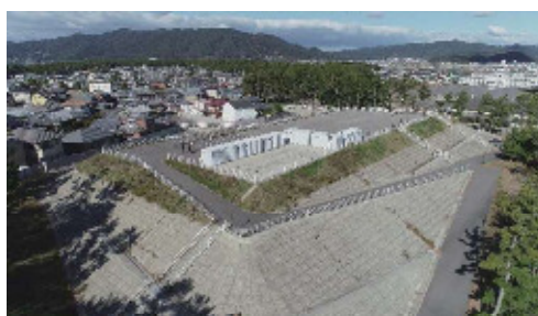
写真 4.30 松原地区高台津波避難場所 (A)
