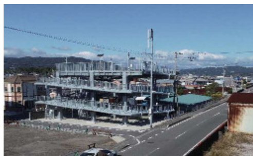
写真 4.34 延命タワー (津波避難タワー) (C)
