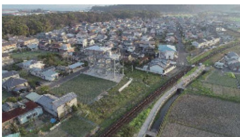
写真 4.17 町地区津波避難タワー
