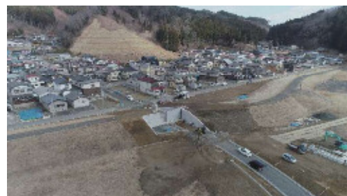
写真 4.10 完成した開閉式の水門（2022 年 3 月）
