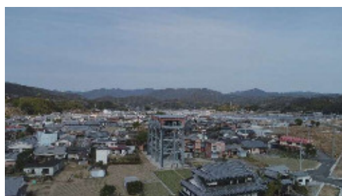
写真 4.18 早咲地区津波避難タワー
