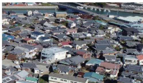
写真 4.33 浜ノ瀬区津波避難タワー(公民館隣接) (B)
