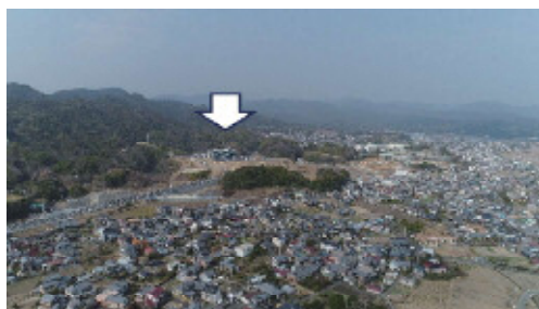
写真 4.21 高台移転した黒潮町役場
