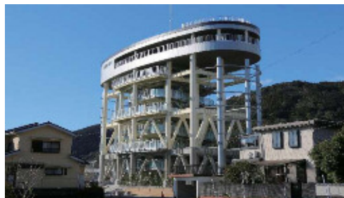
写真 4.20 佐賀地区津波避難タワー（撮影、2019年）
