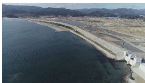
写真 4.1 陸前高田市市中心部・高田地区の巨大防潮堤
