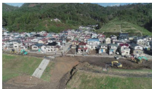
写真 4.9 東日本台風による冠水被害後（2019 年 10 月）
