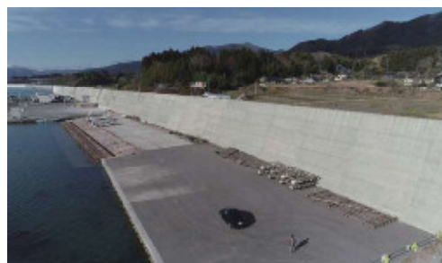
写真 4.2 地域を分断し視界を遮る防潮堤
