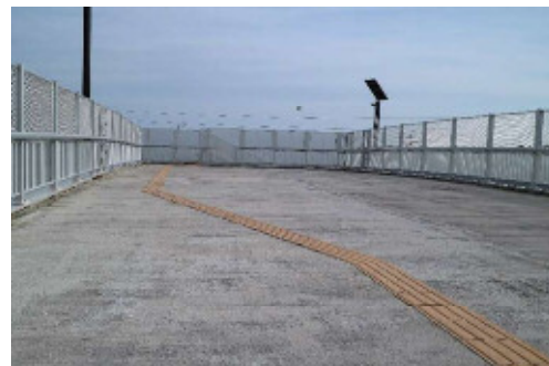
写真 4.46 津波避難タワー B の避難場所
