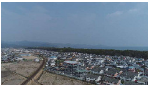
写真 4.15 万行地区津波避難タワー
