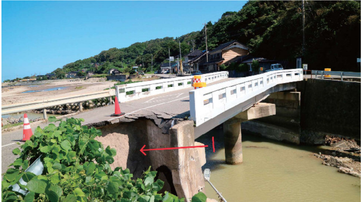
珠洲市県道 52 号線と折戸大橋
