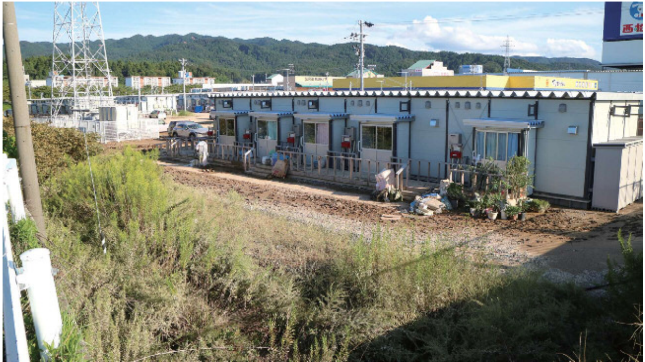
輪島市宅田町の洪水被害にあった仮設住宅
