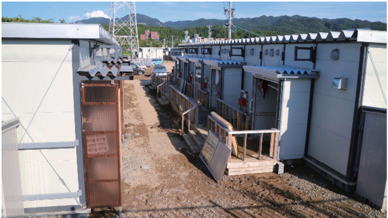
輪島市宅田町の浸水被害にあった仮設住宅
