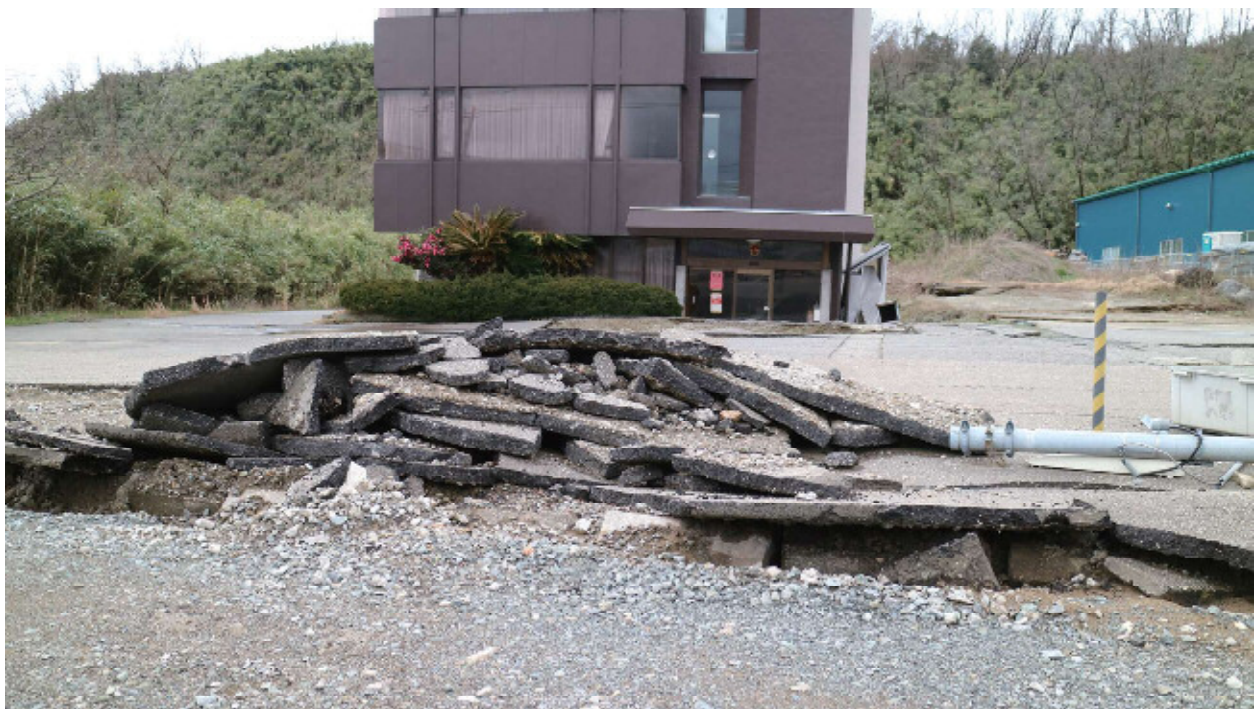
内灘町西荒屋地区の液状化被害 同上。(2024年2月中旬、カメラ撮影)
