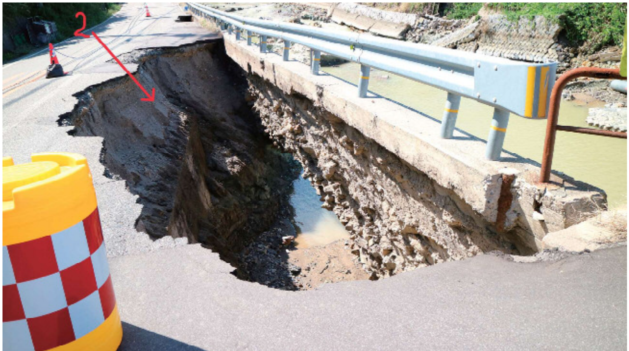
珠洲市県道 52 号線と折戸大橋
