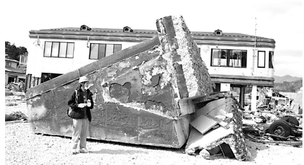
山田町の基礎工事のない防潮堤 (2011年4月)
