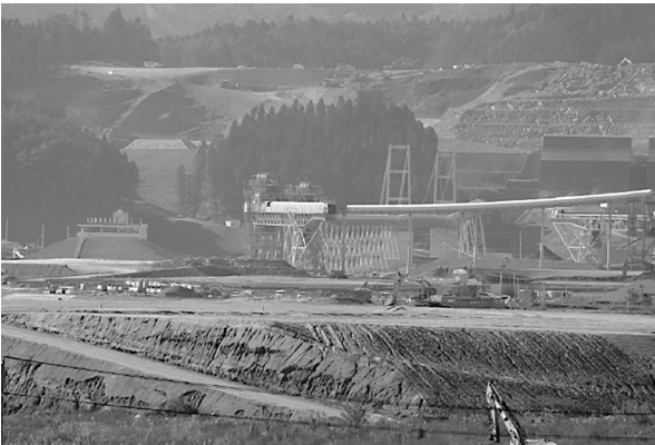
14.5mの高さに嵩上げ工事中高田地区 (2017年)
