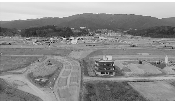
14.5mの高さに嵩上げ工事中高田地区 (2017年)
