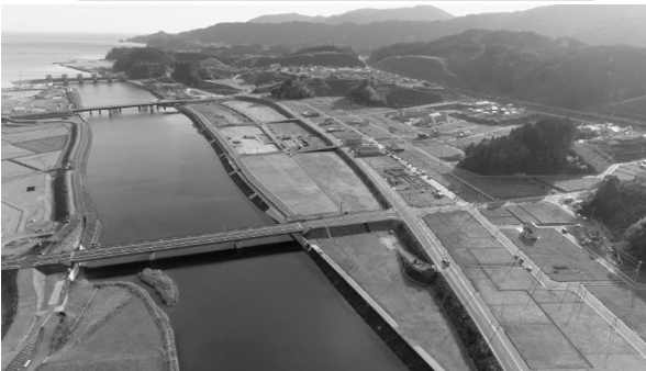
土砂搬出後の造成地と三陸道
