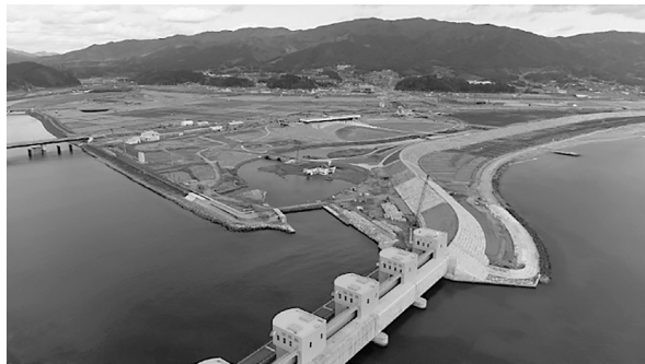
中心部・高田地区の巨大防潮堤
