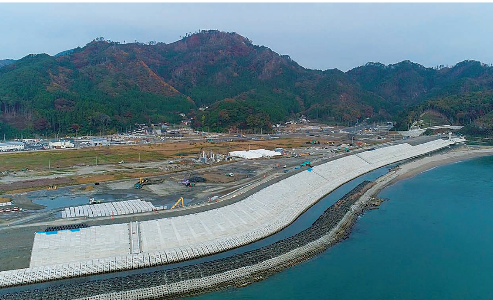
上空100mから見た釜石市鶴住居町で建設中の防潮堤(ドローン空撮):2017年11月 佐藤孝治教授撮影
