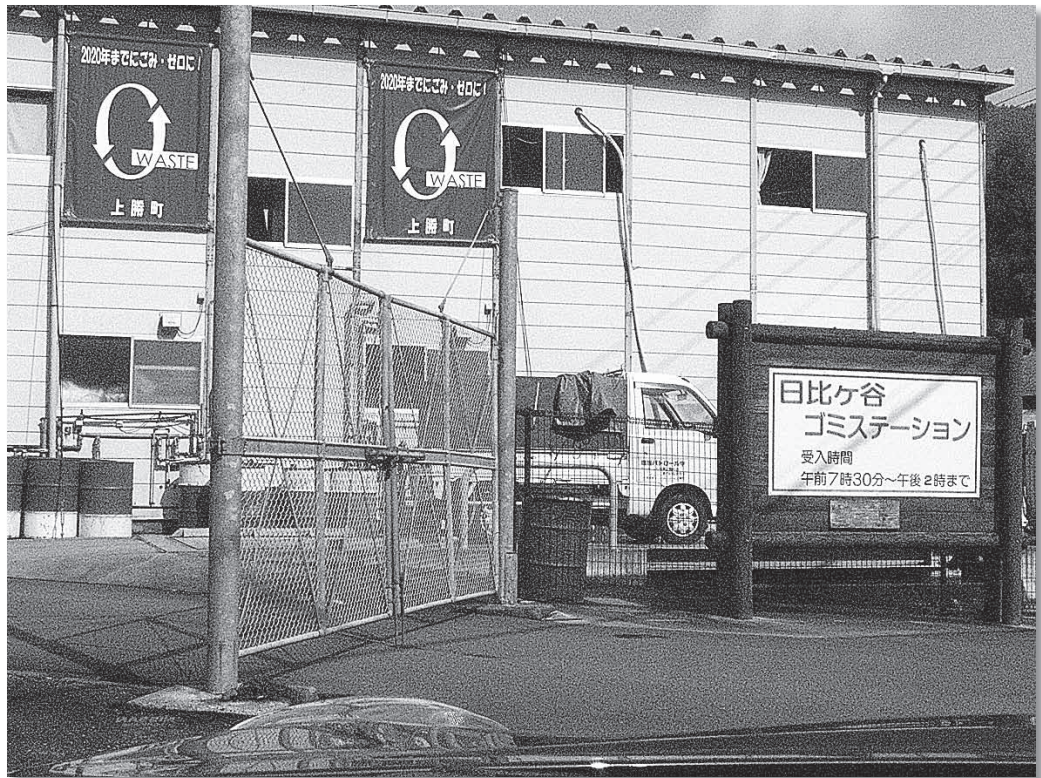
【写真2】日比ヶ谷ゴミステーションの全景
