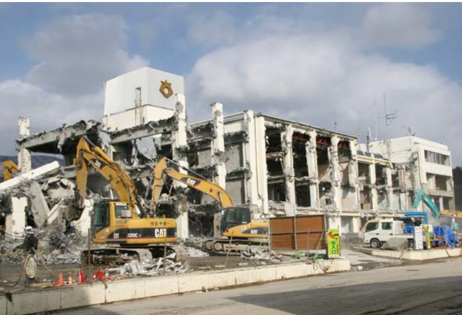
震災から約2年経ち、解体作業が始まった陸前高田市役所：2013年2月9日 佐藤孝治教授撮影
