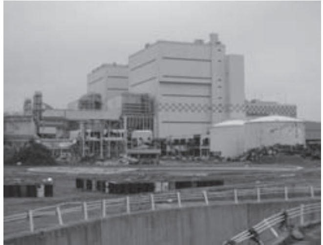
震災6か月後の原町火力発電所 (津波で破壊されたまま)
