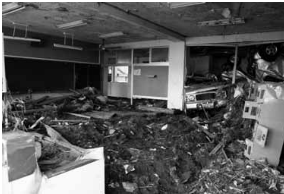
荒浜小学校の遠景（上）と校舎内に流れ込んだガレキ（下）（いずれも4月15日撮影）
