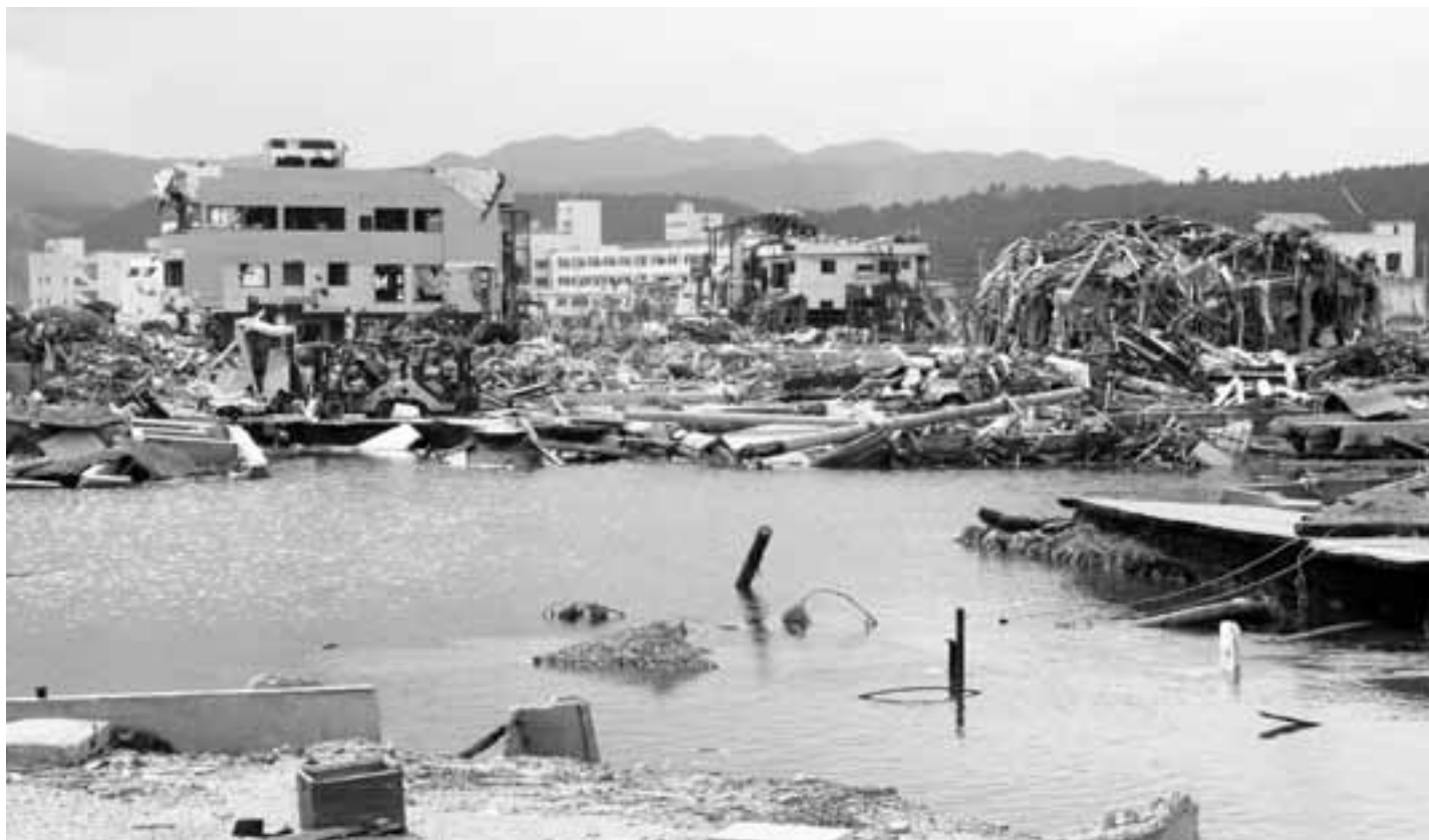
宮城県南三陸町の状況（上は南三陸町の防災庁舎、下は防潮堤付近：5月6日撮影）
